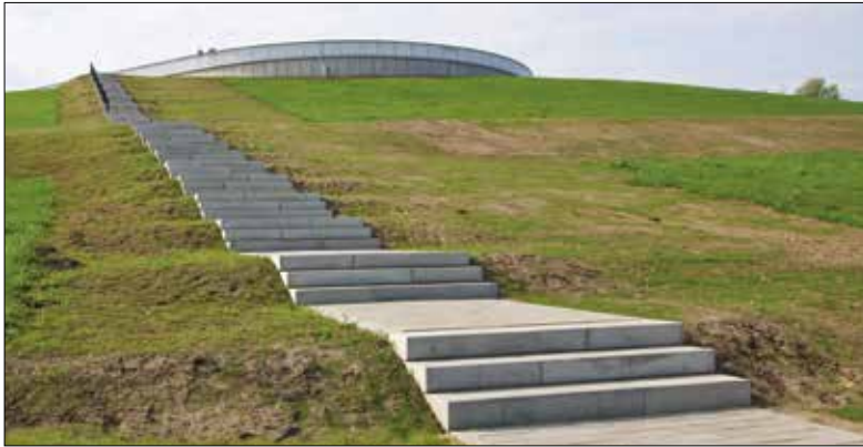
Der Aufstieg führt vom Infozentrum auf den Energieberg in Georgswerder
